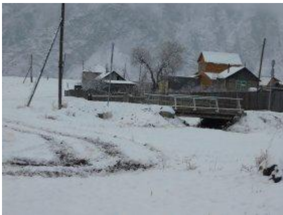
Рис. 12.- Автомобильный мост на ул. Центральная (0,400 км) с. Эдиган Куюсского сельского поселения (требуется новое строительство)
